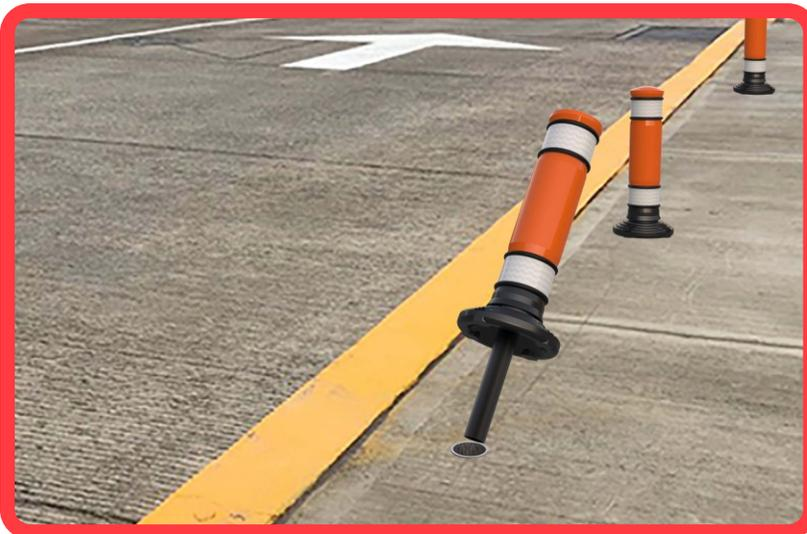
Marcar la posición de los barrenos donde van a entrar los postes, haga un socavón de  $\text{Ø } 2\frac{1}{2}$ " por 30 cm de profundidad, introduzca el poste de polietileno de  $2\frac{1}{2}$ " x 26 cm, nivele y ahogue con cemento, deje secar y estara listo para usar cuando sea necesario.
