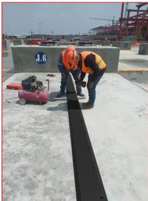
Con ayuda de un taladro con broca de 3/8" para concreto, marcamos todos los barrenos del canalizador, sirviéndonos como plantilla el mismo, perforamos el área asignada a una profundidad de 2/5", introduzca los taquetes en los barrenos, ensamble el canalizador, inserte la pija de 1/4" con sus rondanas de 1/4", con la ayuda de un dado 7/16"; apriete los tornillos perfectamente.
