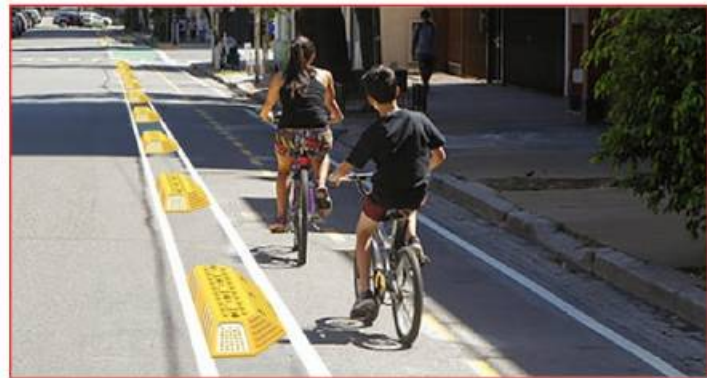
Se ancla al piso con 7 clavos 1/2" x 10" y resina epoxica
