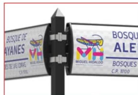
Instalación con fleje
